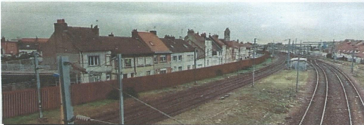
Dans le secteur passerelles, SNCF Réseau propose de retenir la solution d'un écran de 2,5 mètres au lieu de 4 mètres.
