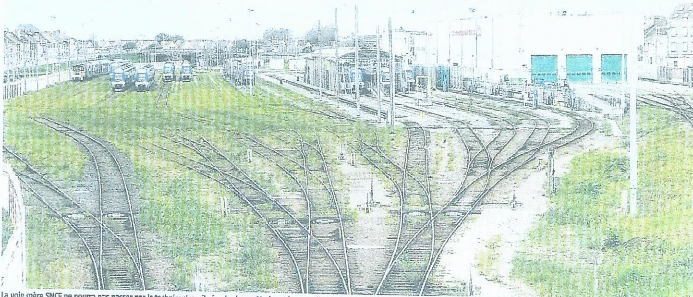
La voie mère SNCF ne pourra pas passer par le technicentre, situé entre la rue Hothe et la rue Colbert.
