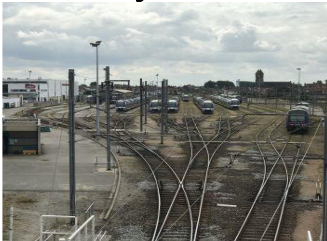
Cet été, à l'issue de la visite de Guillaume Pepy, la solution du passage par le technicentre des Cailloux n'avait pas convaincu la CGT des cheminots.
